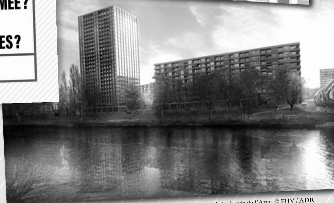
Vue depuis les bords de l'Arve. © FHV / ADR
