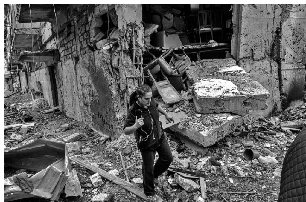
Les quelques mois de guerre ont dévasté la région du Haut-Karabagh. Photo : Yan Boechat/VOA https://commons.wikimedia.org/wiki/File:Destroyed_housing_complex_in_the_Republic_of_Artsakh_due_to_bombardment_from_Azerbaijan_in_September-October_2020.jpg
